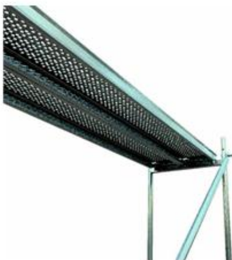
Rys. 6. Montaż pomostów stalowych pierwszego pola rusztowania
